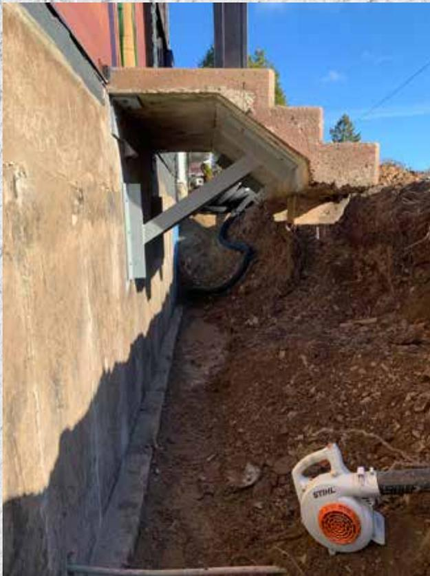
Lorsque l'excavation est terminée, nous procédons donc au nettoyage de la fondation à l'aide d'un jet d'eau à haute pression. Cette étape est cruciale puisque nos produits n'adhèrent pas à une fondation mal nettoyée et comportant encore des débris. Une fois le nettoyage de la fondation terminé, nous pouvons établir un plan de match pour la réparation des fissures de fondation, les trous à boucher ainsi que toute anomalie nécessitant une intervention particulière.
