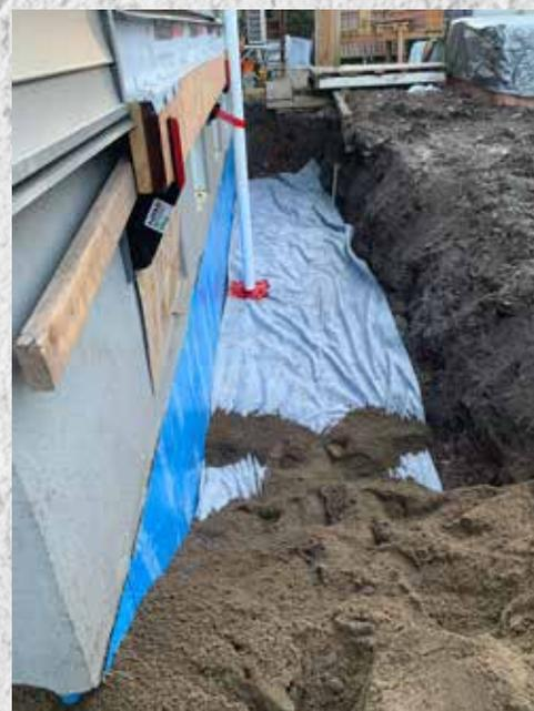
Nous installons au fond de la tranchée une membrane géotextile afin de filtrer les sédiments qui pourraient véhiculer avec la nappe phréatique. Le drain rigide de 4" BNQ sera déposé sur cette membrane géotextile. Plusieurs contracteurs déposent simplement le drain au bas de la semelle de fondation sans se soucier de la hauteur du plancher intérieur, il s'agit de la plus grosse erreur la plus souvent commise.
